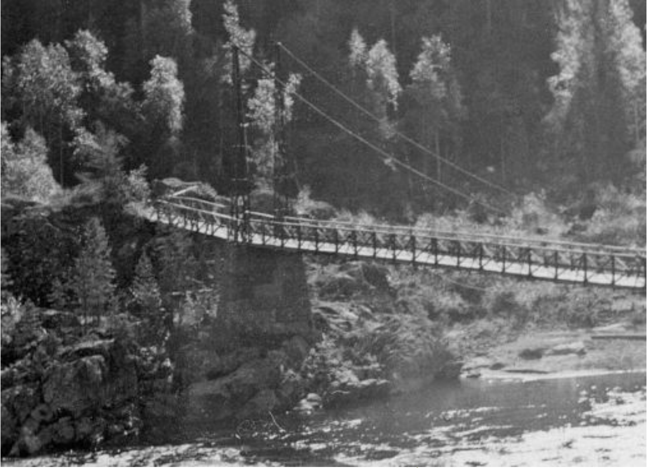
Hängbrons norra sida. Foto lånat ur Kjell Olssons samlingar. Årtalet okänt. Lägg märke till avståndet mellan bron och vattenytan. Uppskattat till ca.8meter./ GO
